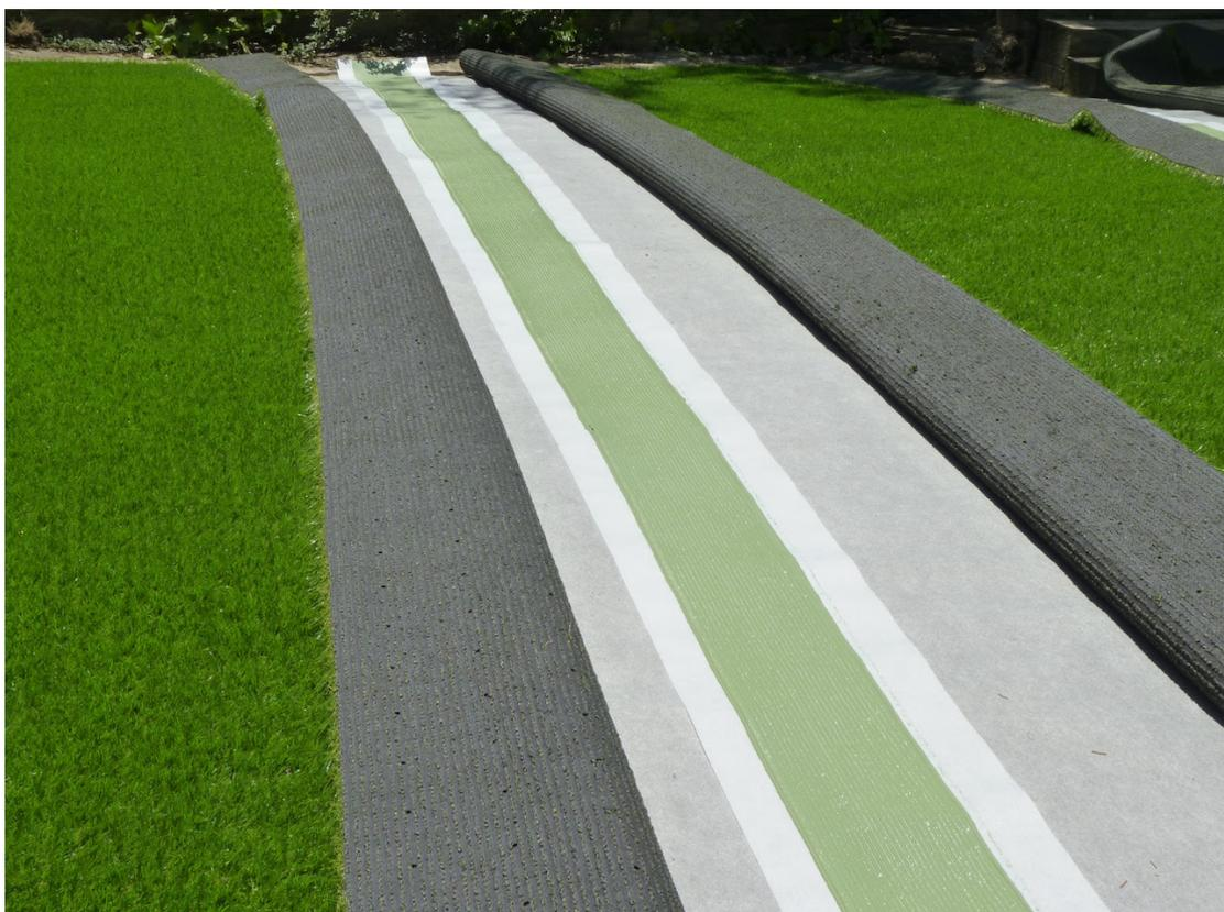
Fijar primero sobre la cinta de unión (con cola) un lateral y después con cuidado ajustaremos el otro dejando siempre una pequeña separación entre ellos (galga) para evitar que monte uno sobre el otro.
