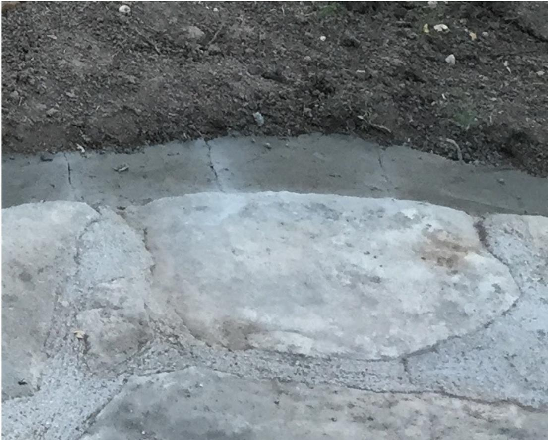
Hay que repartir el material de relleno/regularización uniformemente sobre toda la zona a instalar. El material de relleno/regularización debe de ser un material que cuando este compactado sea agradable a la pisada pero se quede compactado para que no ceda la base al ser pisada. La base deberá estar bien compactada para evitar que ceda y regularizada para evitar que las irregularidades produzcan arrugas en el césped. Es muy importante que quede una base sin desniveles importantes.
