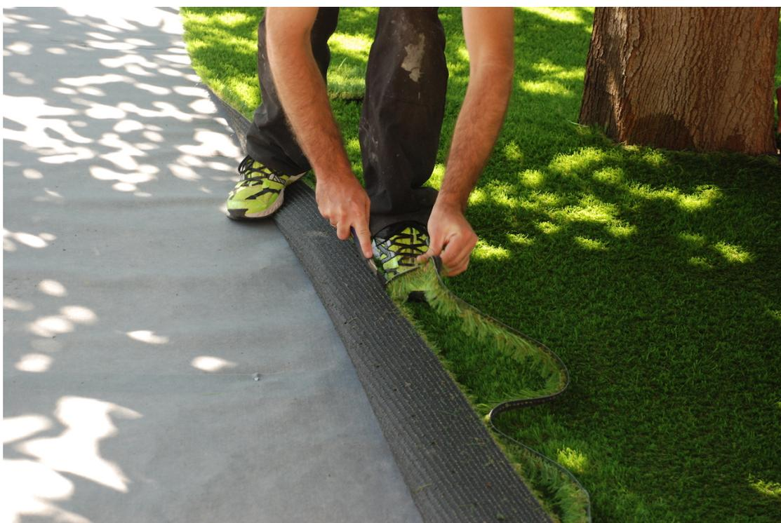
Instalar la cinta de unión y aplicar la cola (bicomponente) que previamente habremos mezclado y batido.
